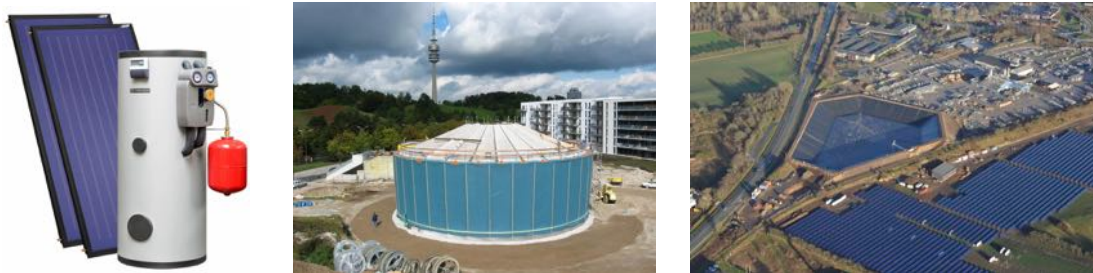
Abb.2-1 Unterschiedliche Arten von Warmwasserspeichern: links: Pufferspeicher für den dezentralen Einsatz, Mitte und rechts: saisonale Speicher für Wärmenetze
