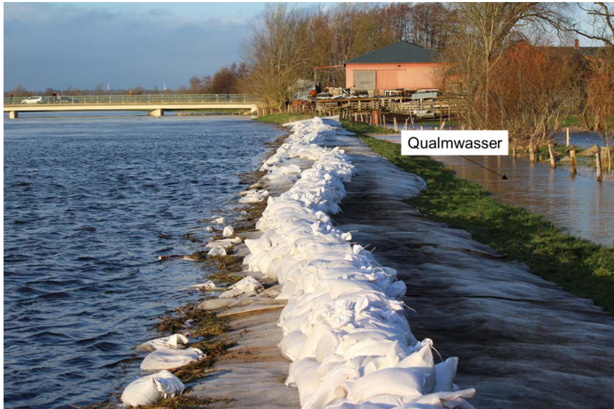
Abb. 3: Sicherung des Treenedeichs bei Hollingstedt
