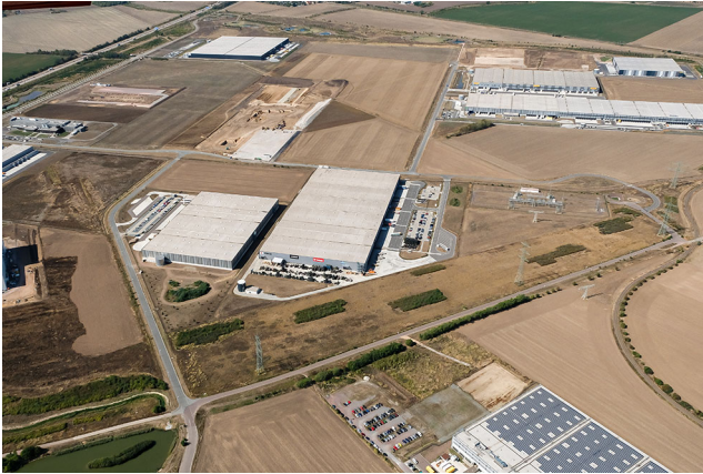
Abbildung 1 Baustelle zum Neubau eines Logistikzentrums im Stadtteil Peißen in Halle (Saale) (2019) Quelle: euroluftbild.de/Maika Glöckner
