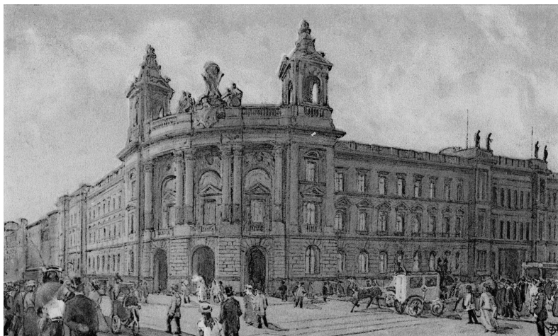
Abbildung 26: Außenansicht des Generalpostamts der Kaiserlich Deutschen Reichspost mit dem Erweiterungsbau des Reichspostmuseums (heute Museum für Kommunikation)
