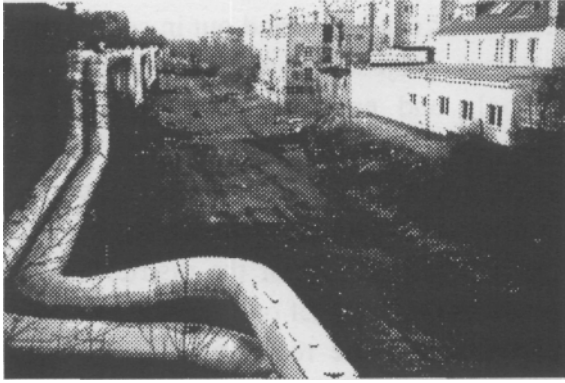
Illustration 8: Anger-Crottendorfer Bahnschneise - View from the Martinsbrücke
